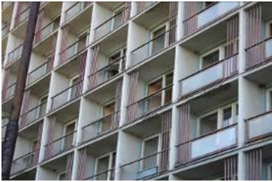
Internát pred rekonštrukciou
